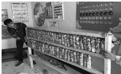
Gambar 3. Memasang botol di rangka pagar
